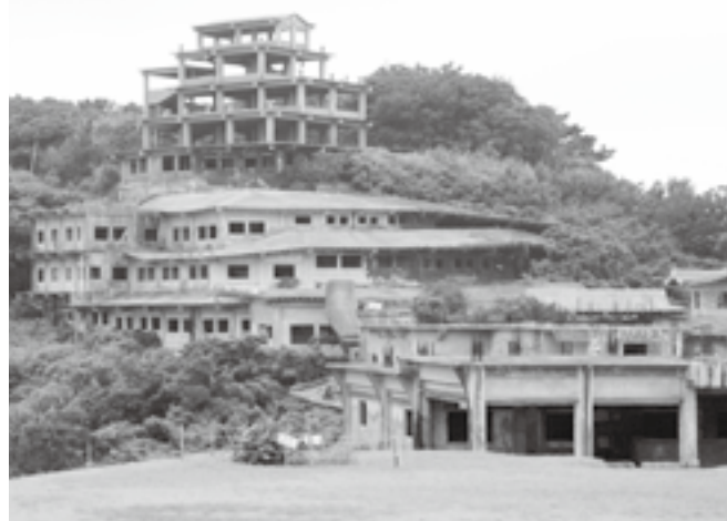
中部の中城に所在する中城高原ホテルの廃墟。海洋博を目指して計画・建設されたが法令違反のため開業できず放棄されたといわれている。わが国を代表するホテル廃墟で、現在は立ち入り禁止。
