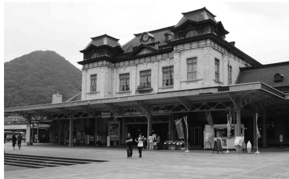
門司港駅・駅舎
